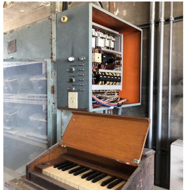
図2 ヤマハミュージックサイレン初号機につながっていた鍵盤型スイッチ（ヤマハ本社工場にて）
